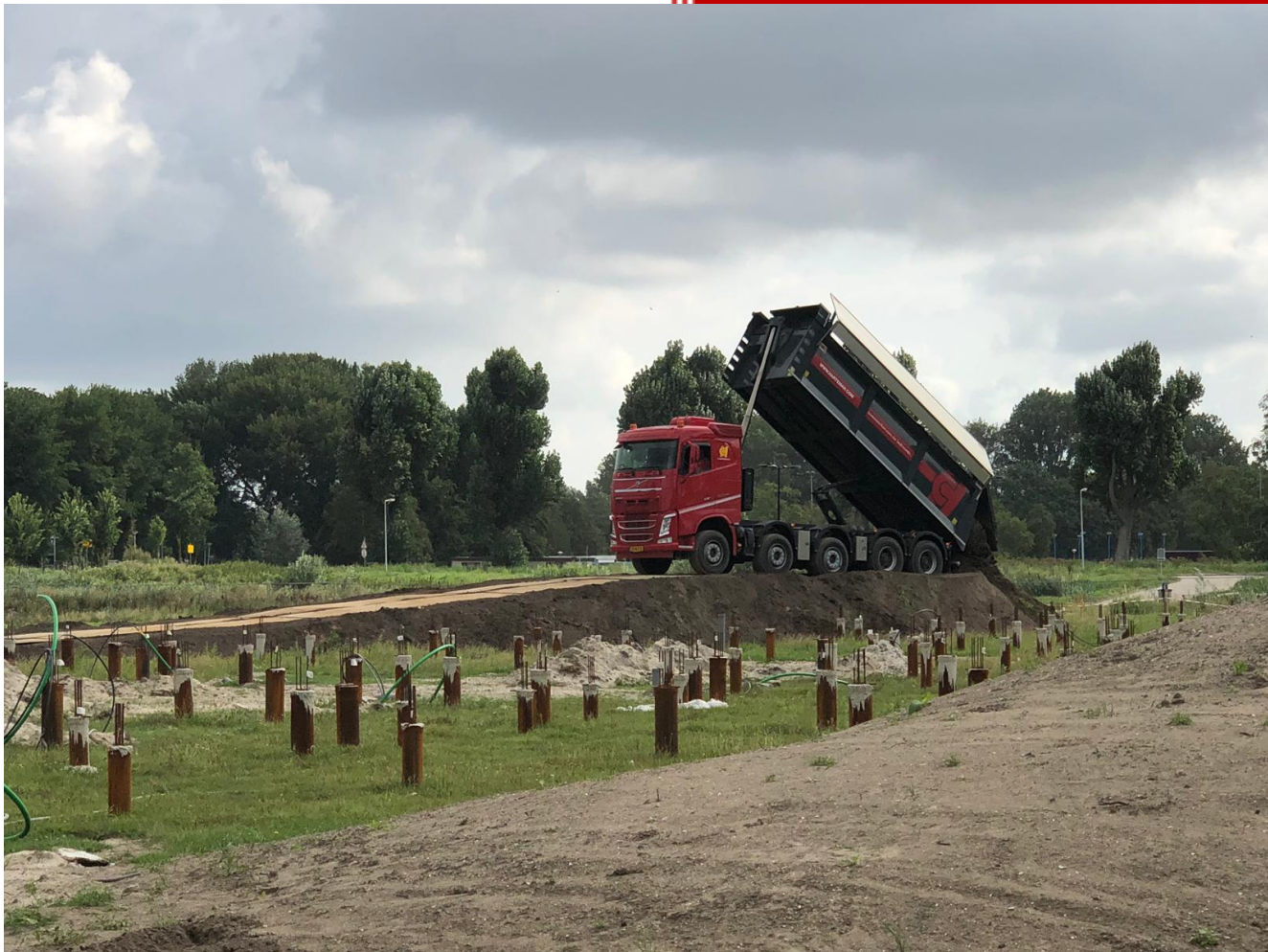
Afbeelding 1: Aanleg windmolenpark te Geldermalsen 2019
