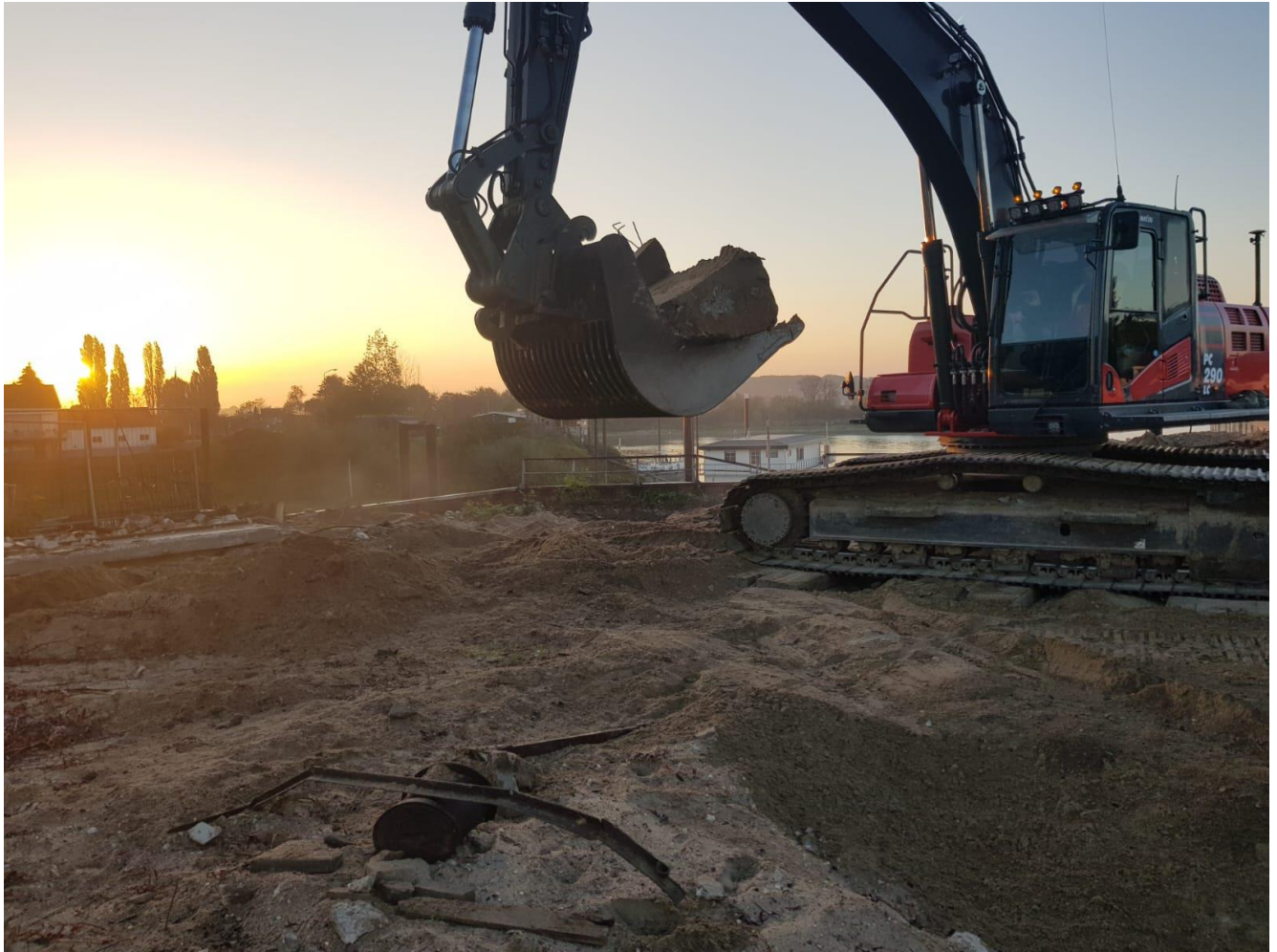
Afbeelding: bodemsanering aanbrengen leeflaag voormalig tankstation Havendijk Tiel
